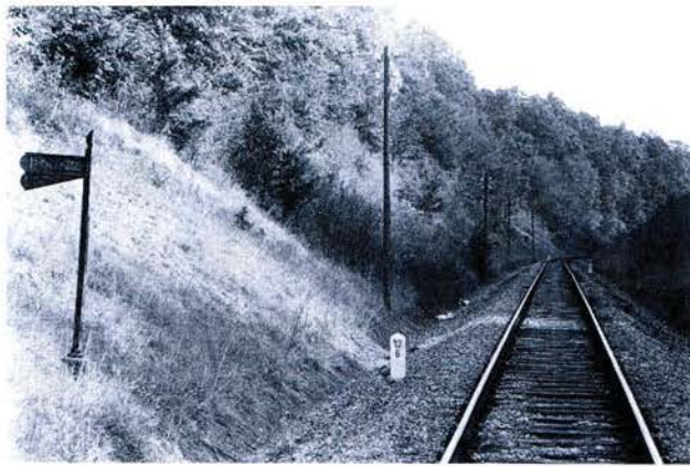
Dieser recht betagte Neigungsanzeiger fand sich am 11. September 1971 an der Strecke Tübingen – Herrenberg bei Breitenholz.
